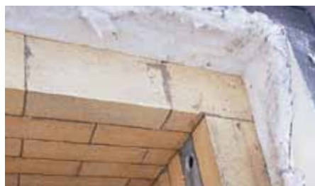
Die Brennkammer, mit Mehrfachisolierung und hochwertige Schamottierung.
